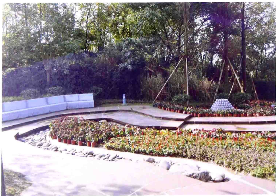
图 1-4 根据地形关系在铺装边缘铺设河石，实现排水功能，既简单又让环境充满生机。
