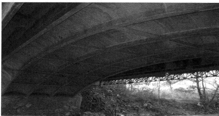
图3 加固后的桥梁上部结构
