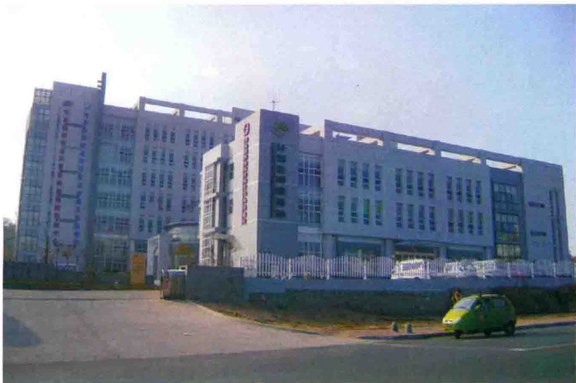
青岛多元建设集团承建的区卫生综合楼工程
