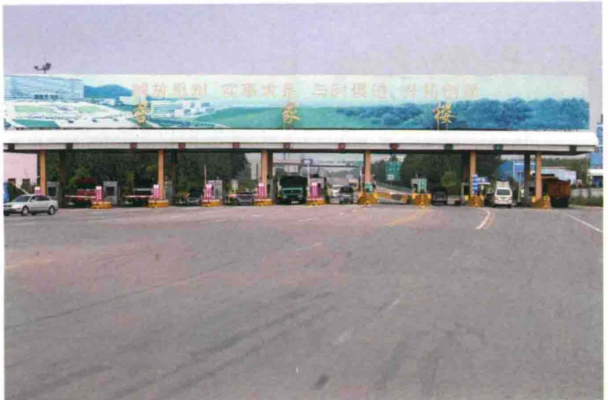
胶州湾高速公路
