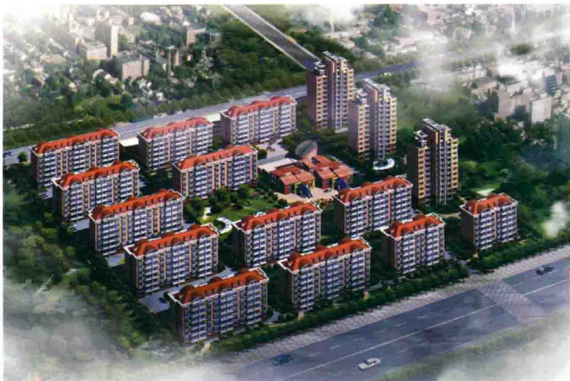
山东兴华建设集团开发建设的“兴宝苑”住宅小区工程
