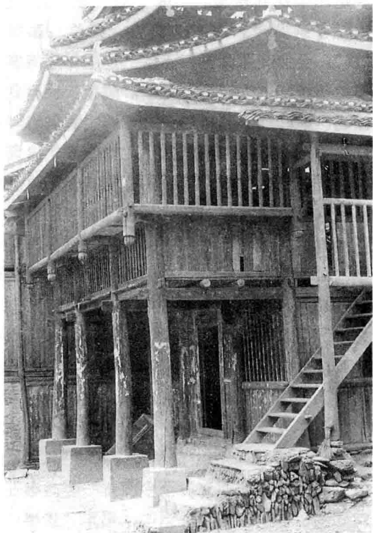
图 1-16 鼓楼底层外檐柱“侧脚”，通道，高步
