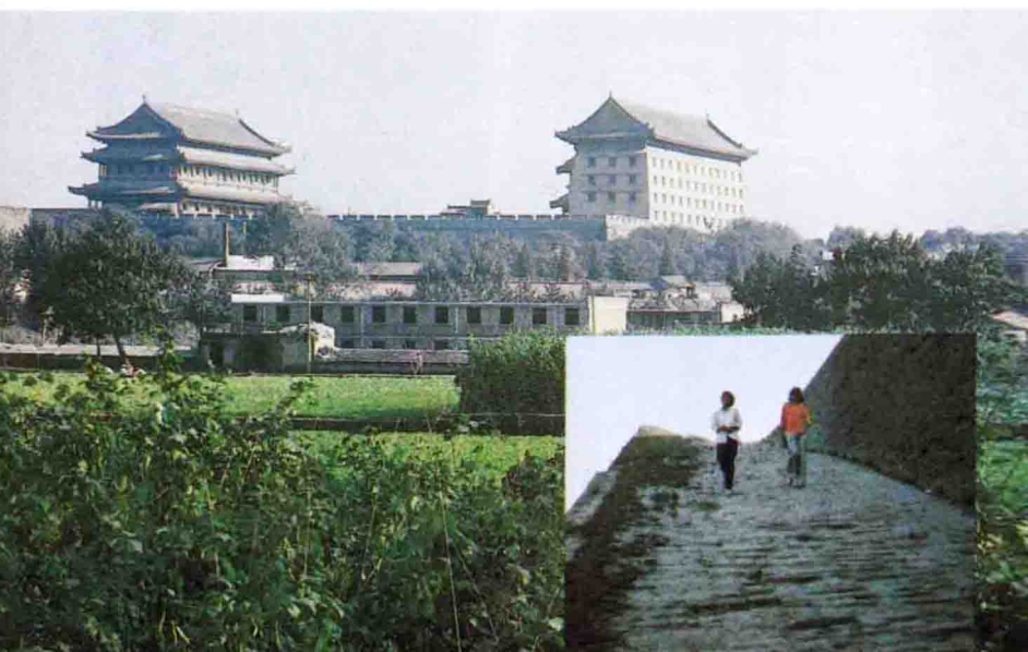
西城门楼和城墙马道
