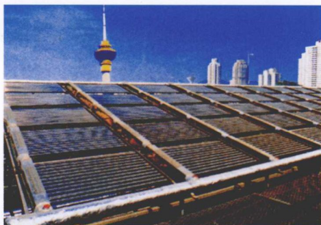
图6 真空管热水工程（北京）
