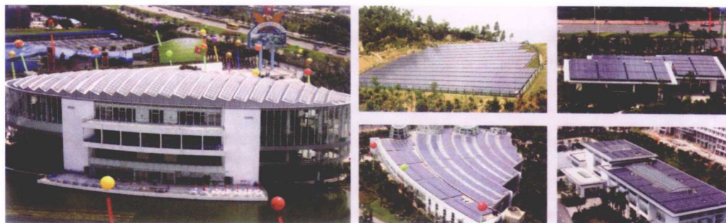
图 12 深圳国际园林花卉博览园 1MWp 太阳能光伏并网电站
