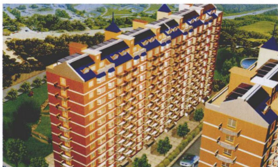
图5 大型住宅真空管热水工程（四平）
