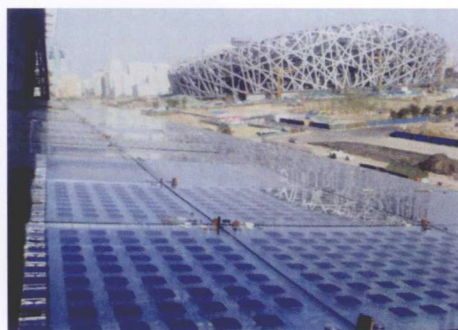
图11 国家体育馆 100kWp 太阳能光伏并网电站
