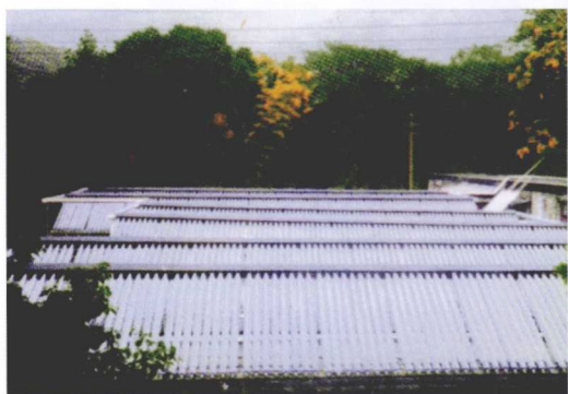
图3 热管真空管热水工程
