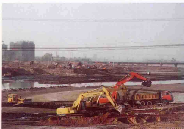
▲ 运河城市段施工现场
