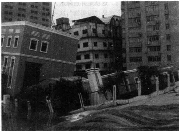
图 1-4 地下水处理不当导致地面建筑物被毁
