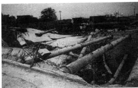
图 1-2 地下水导致建（构）筑物倒塌
