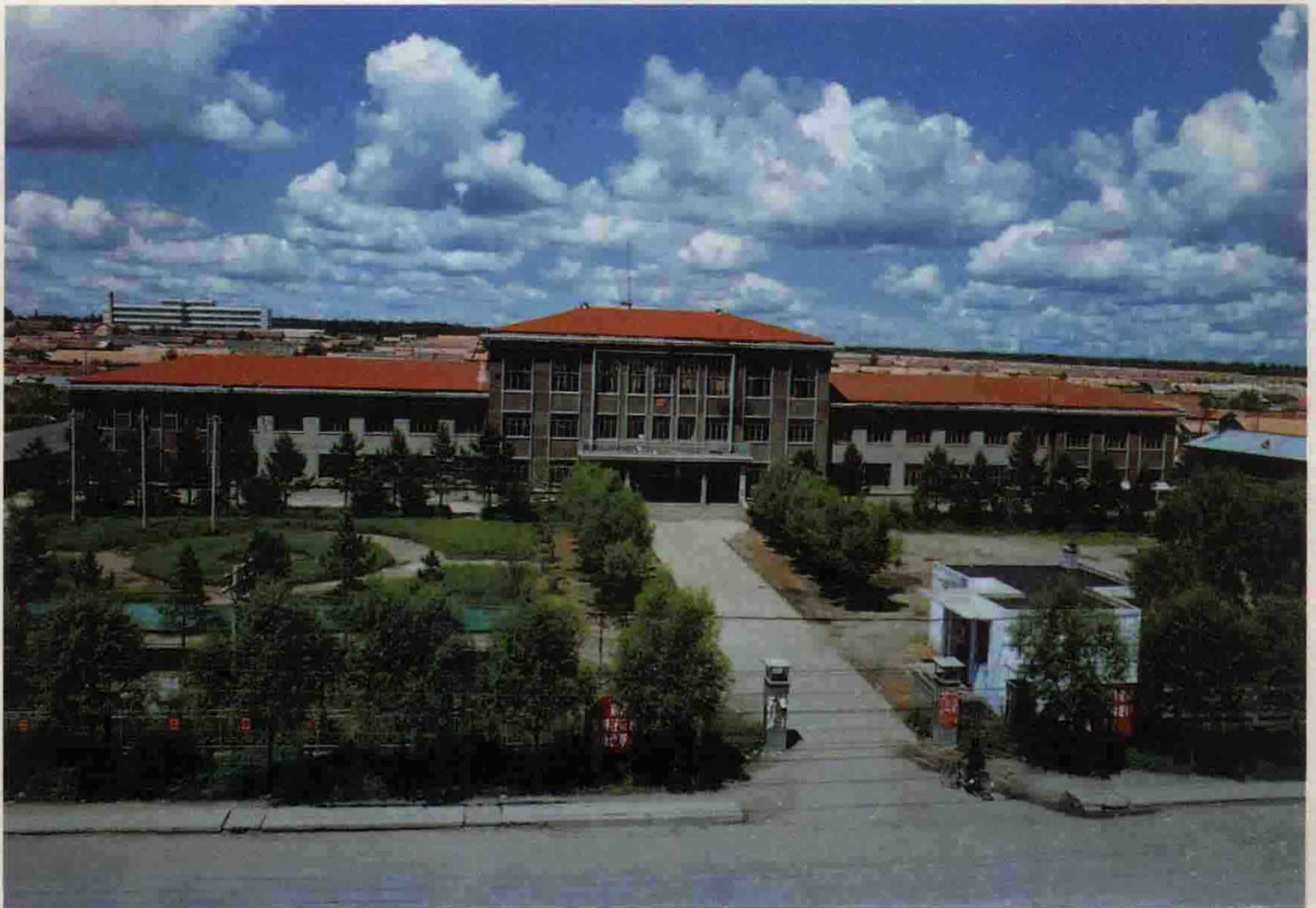
▲ 区政府、林业局办公楼
