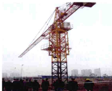
安装塔吊 造成高坠
