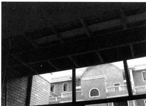
图1-7 石膏板、扣板吊顶施工
