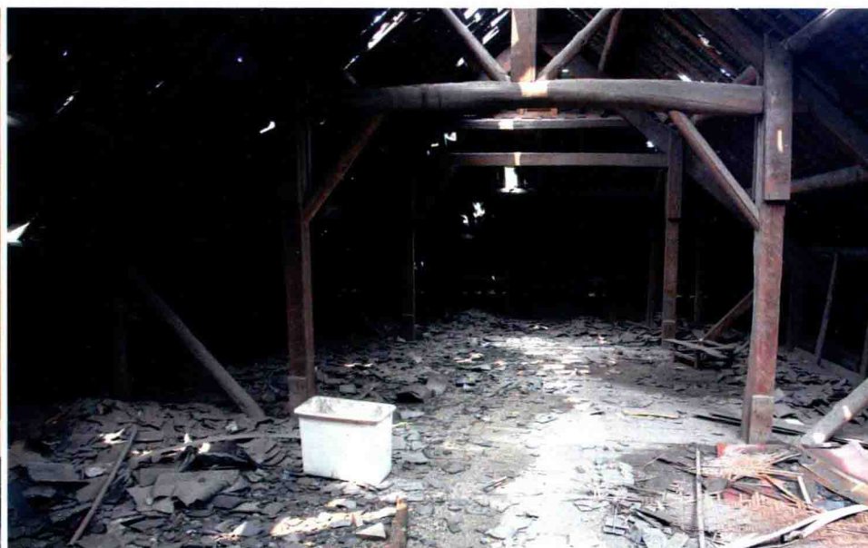
汶川大地震使四川大学遭受严重破坏，经济损失约8亿元
