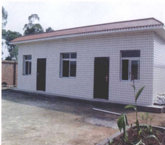
15 基准站土建完成后有参照物的近景照片
