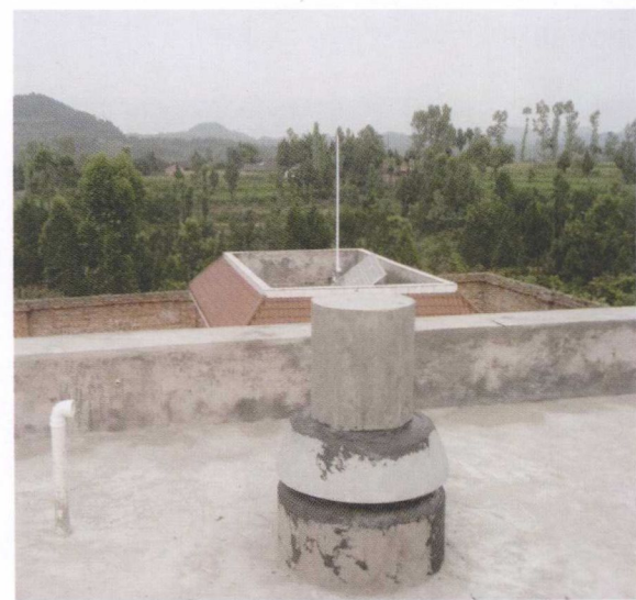
14 观测室屋顶照片
