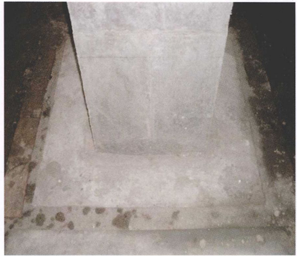
10 隔震槽施工
