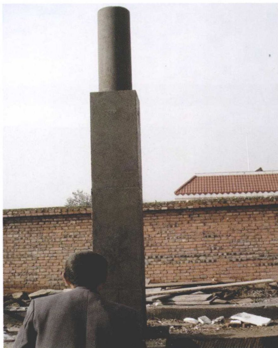
07 GNSS 观测墩建成拆模后
