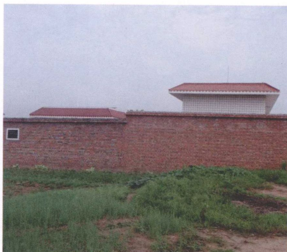
16 基准站土建完成后有参照物的远景照片
