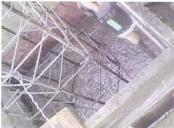
03 GNSS 观测墩地下部分浇筑过程
