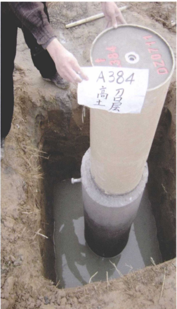
05 拆模后掩埋前
