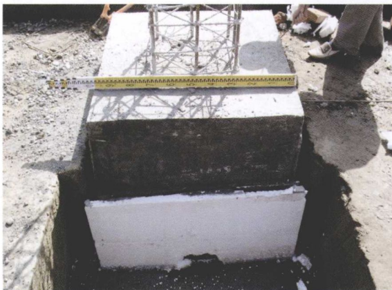
05 GNSS 观测墩地下部分浇筑拆模后 回填土后
