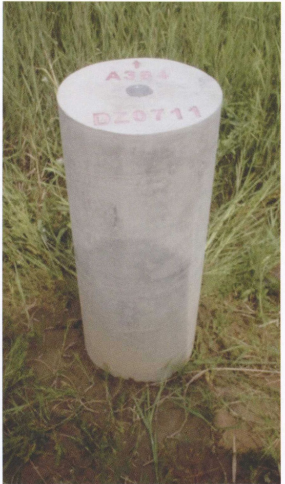
06 观测墩掩埋后近景
