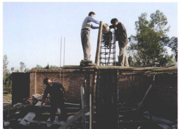
06 GNSS 观测墩地面以上部分浇筑过程
