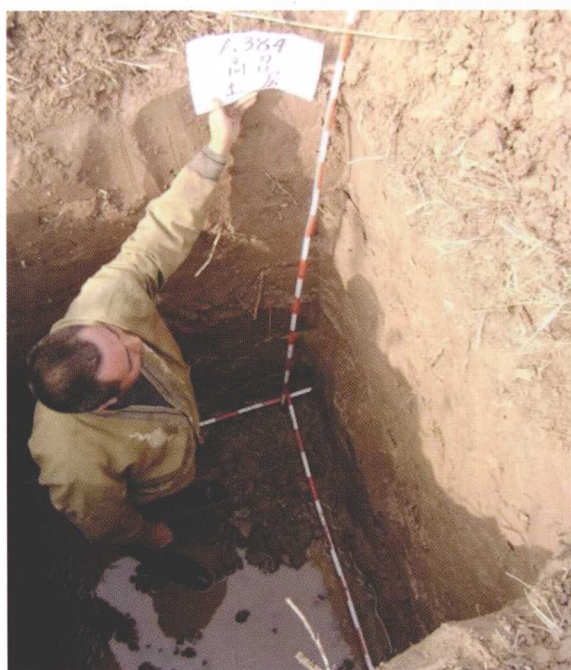
01 观测墩基坑开挖
