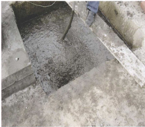
09 重力观测墩地下部分浇筑过程
