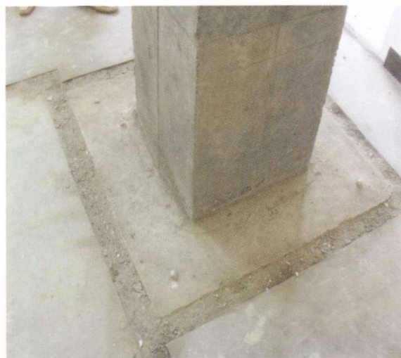
11 GNSS 观测墩建成后
