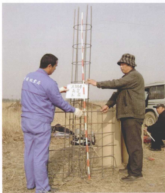
02 钢筋捆扎及钢筋笼下放
