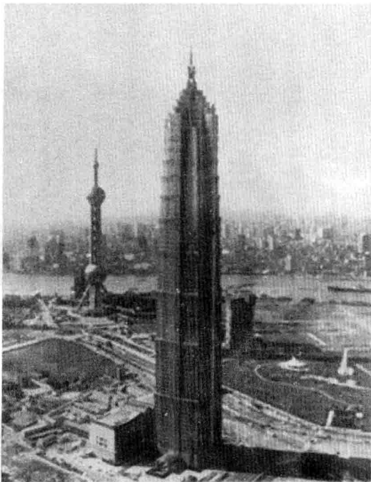
图 1-2 高层钢结构建筑
