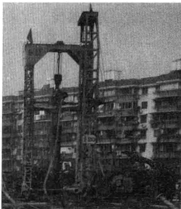
图6.3-2 钻孔灌注桩机
