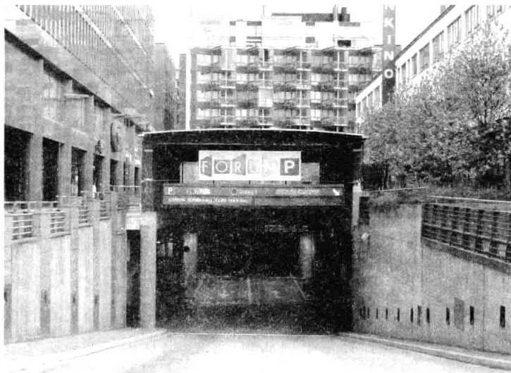
图 1.1.8 地下停车场入口
