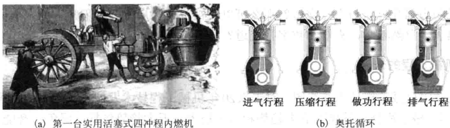
图 1-1 尼古拉斯·奥托设计的四冲程内燃机
