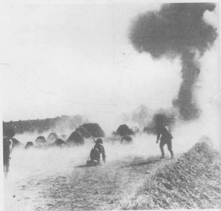
1949年1月3日至12日，东北野战军在扫除天津敌外围据点时，各纵队组成爆破组随突击队实施爆破。
