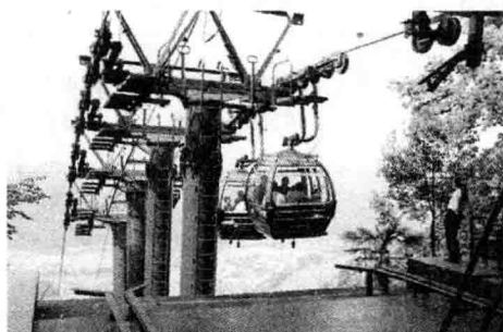
图 1-6 客运架空索道
