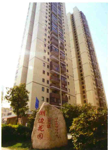
保障性住房湖边花园 B 区
