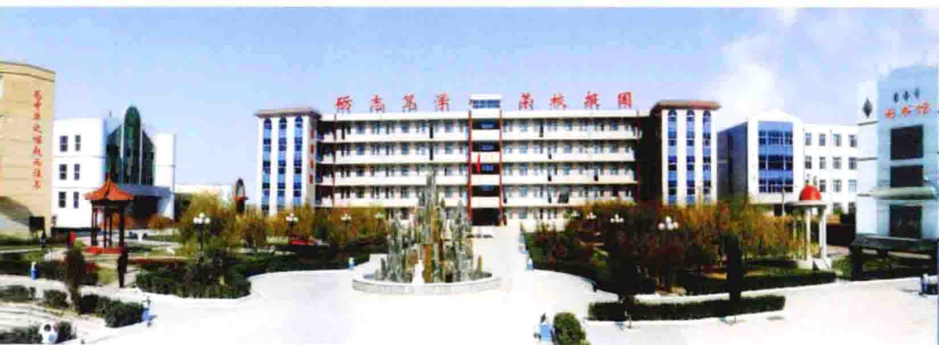
宁晋中学明德楼
