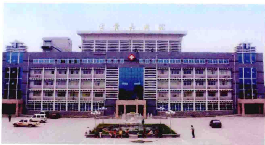
宁晋县医院门诊楼
