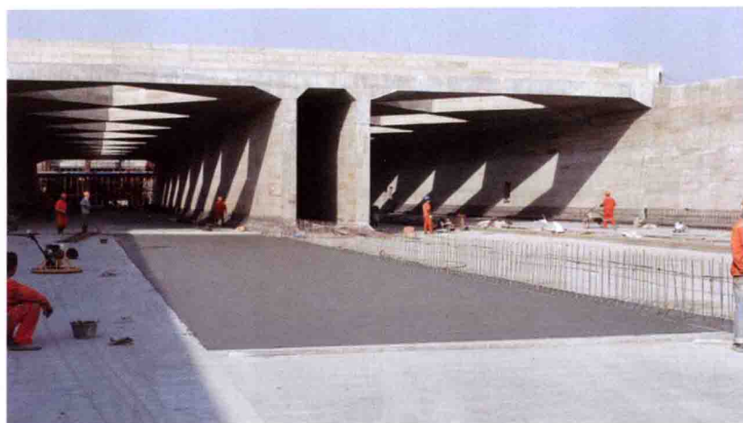
隧道洞口施工
