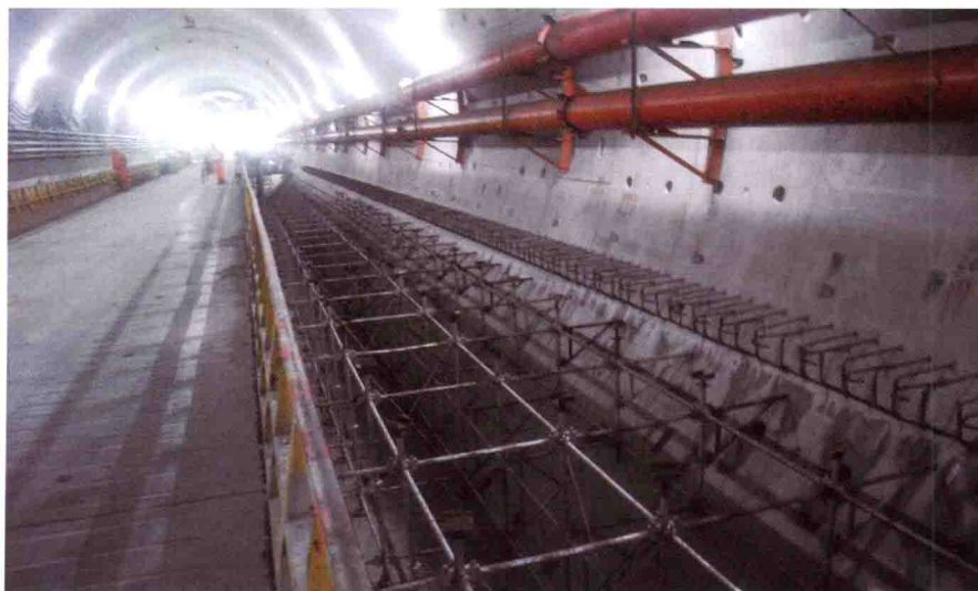
钱江隧道内部施工
