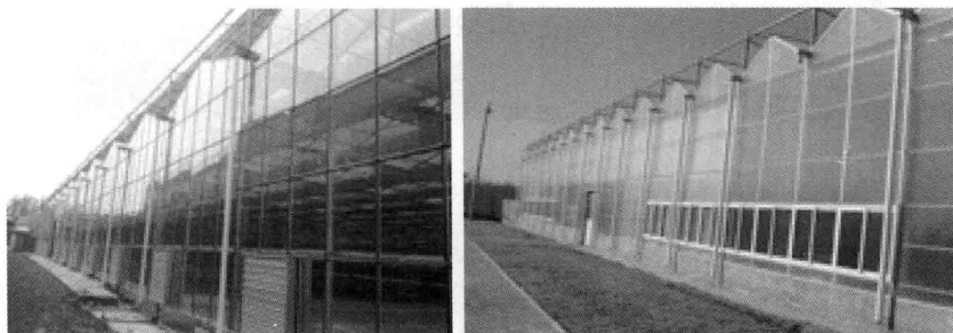
图 1-30 玻璃连栋温室和 PC 板连栋温室
