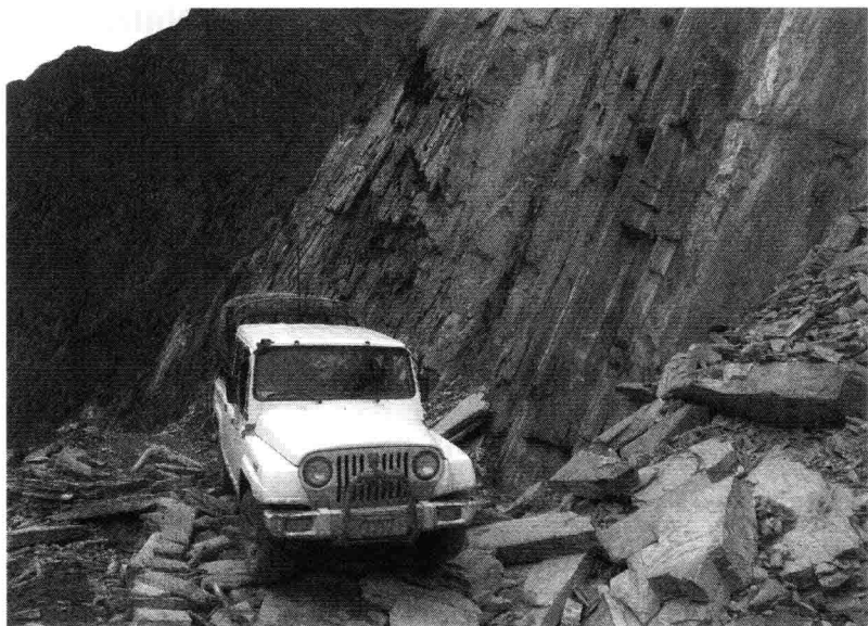
图1 山路塌方 2011年 周建新摄
