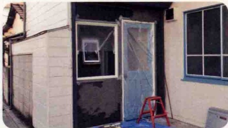
2011年3月 在外墙壁涂抹砂浆
