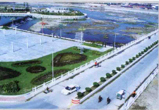
房县西河防洪工程
