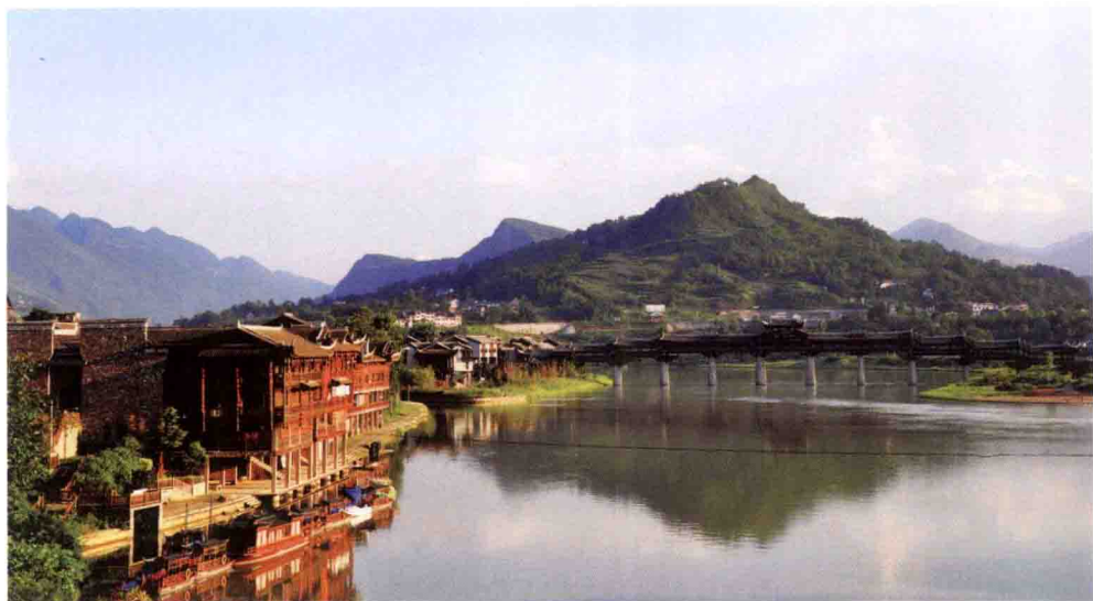
长度亚洲第一、世界第二的风雨廊桥（黔江濯水）
