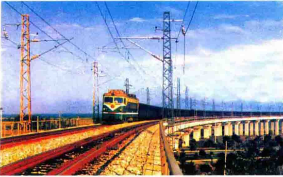
大秦线重载双线电气化铁路
