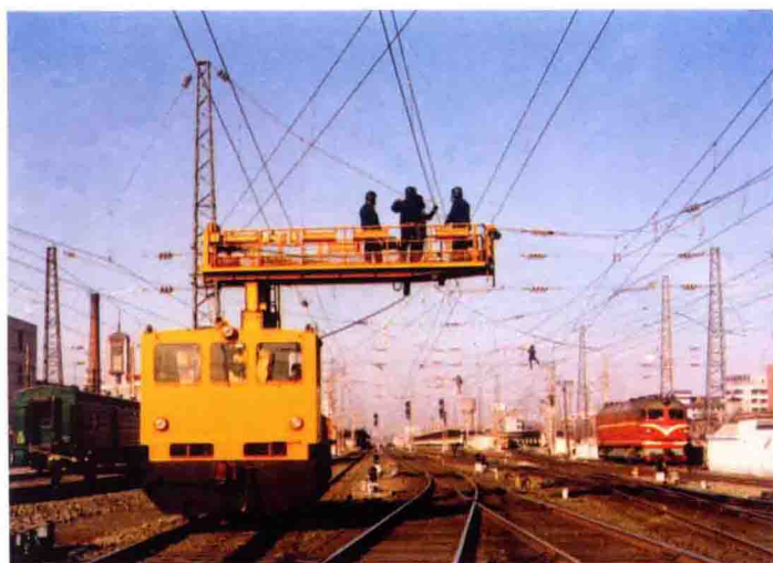
石家庄枢纽电气化施工
