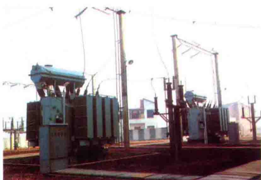
全路最先进的牵引平衡变压器
