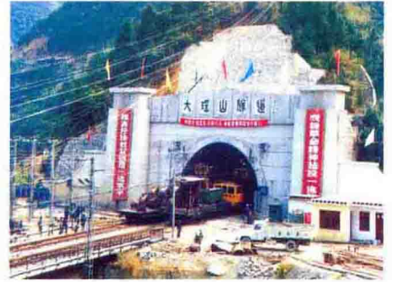
国内最长的大瑶山隧道电气化施工
