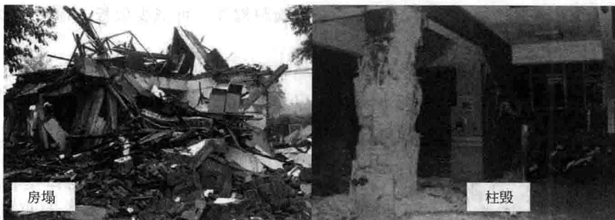
图 1-2 建筑结构承载力不足的教训
