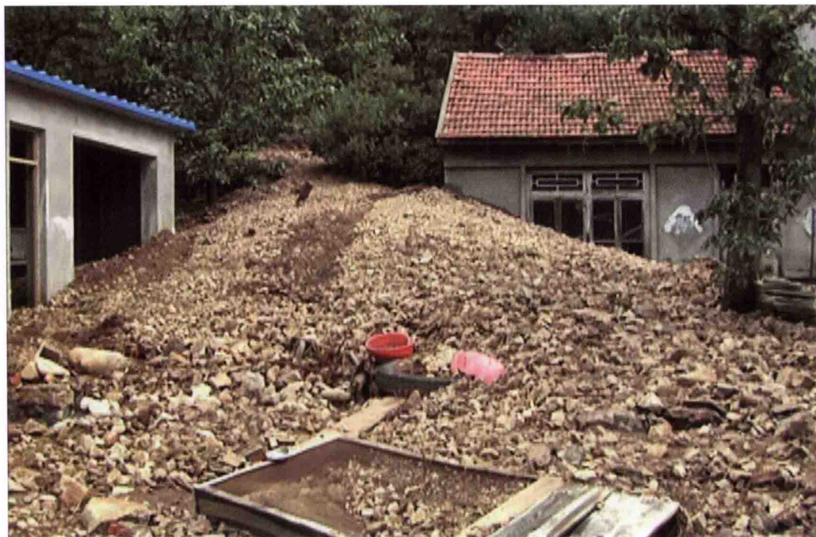
宽甸县虎山镇北荒沟村泥石流损毁房屋
