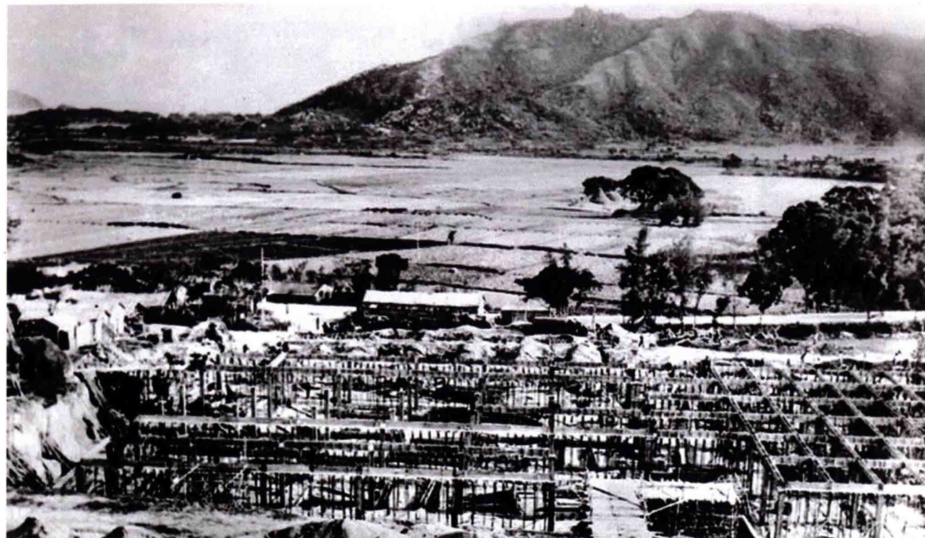
1979年，珠海首个外商投资企业香洲毛纺厂的建筑工地（李志均 摄影）
