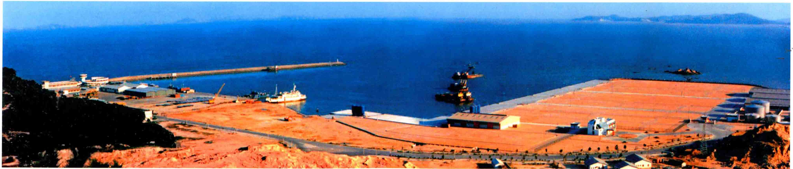
1984年开始建设的九洲港货柜码头全景（李志均 摄影）
