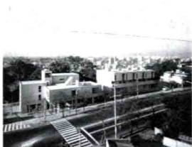
4. 代官山山坡住宅 集合住宅楼群
