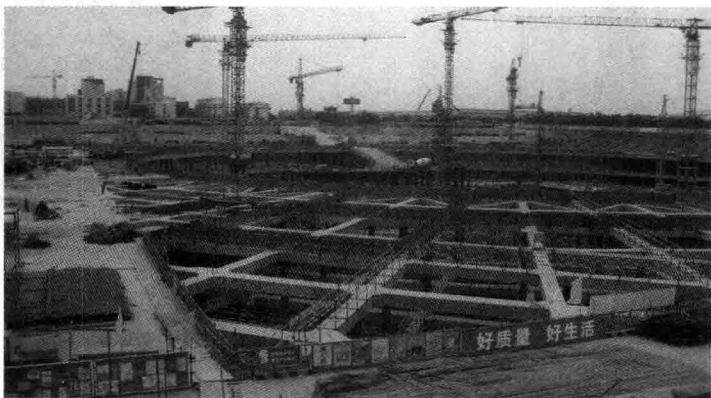
图 1-3 117 大厦施工现场
