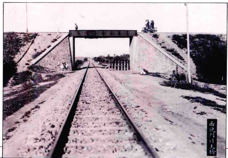
京汉、京张铁路在西便门修建的立交桥（1906年）
