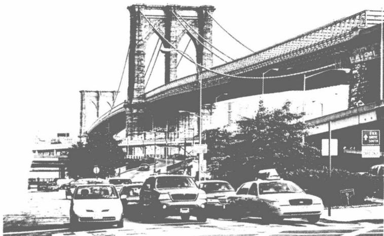
**行**人和车辆都需要借助桥梁,才能在水域、峡谷和道路的上方穿越。如果你向人打听美国有哪些著名大桥,他们一般会推荐加州旧金山的金门大桥和纽约的布鲁克林大桥。这两座桥都是吊桥,它们的跨度很大,其桥面车行道都是被以高塔为支柱的钢索吊起的。
