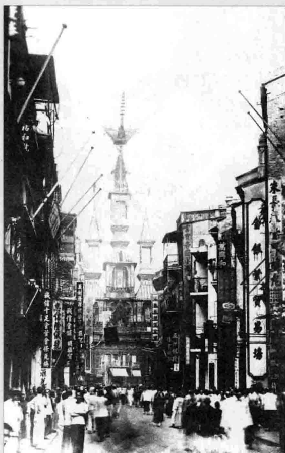
1910年初的金银业贸易场，位于中环电车 路永安公司总店对面
