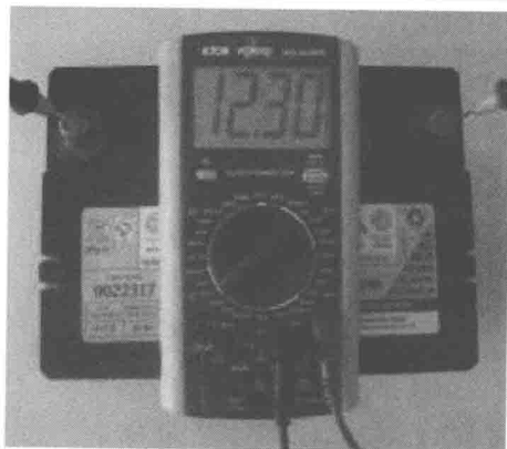
图 1-21 测量蓄电池的电压
