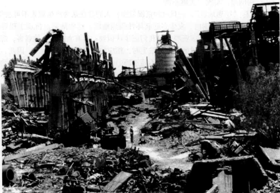
图 1-4 震后厂区场景
