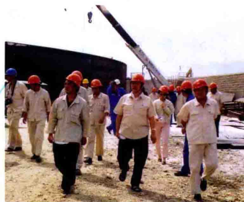
公司经理陈青松率有关领导到锦 州港视察20万立方米罐储油工程万原 油仓储工程
