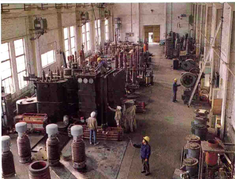
修配厂检修主变压器车间
