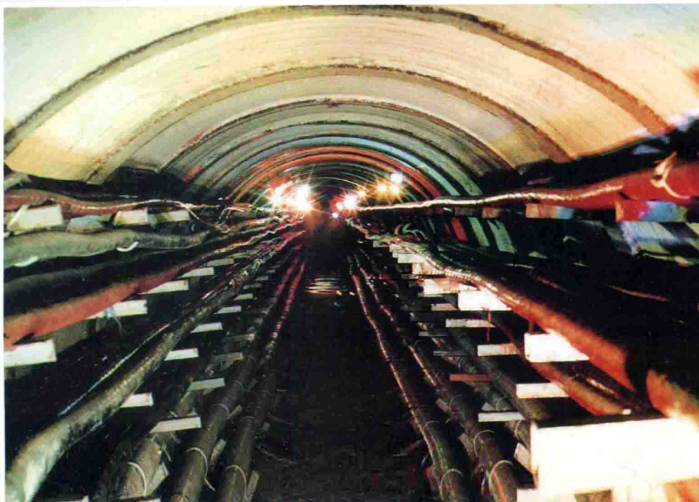
第二热电厂至前门变电站 110千伏电缆隧道
