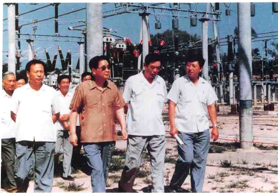
1984年国务院副总理李鹏由华北电业管理局局长李寿琪、副局长张绍贤陪同，视察建设中的500千伏房山变电站
