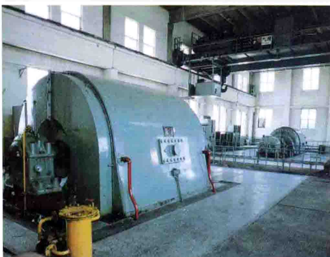
220 千伏老君堂变电站 6 万千瓦调相机
