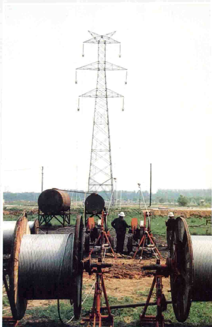
输电线路施工张力放线现场
