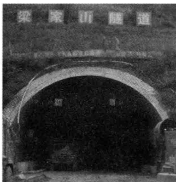
图 2-1 梁家山隧道洞口
