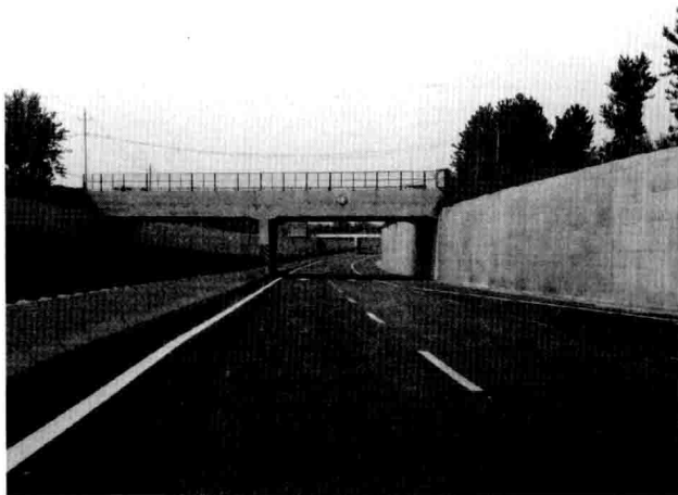
图 1-2 商周二期下穿陇海铁路通车后实景图
