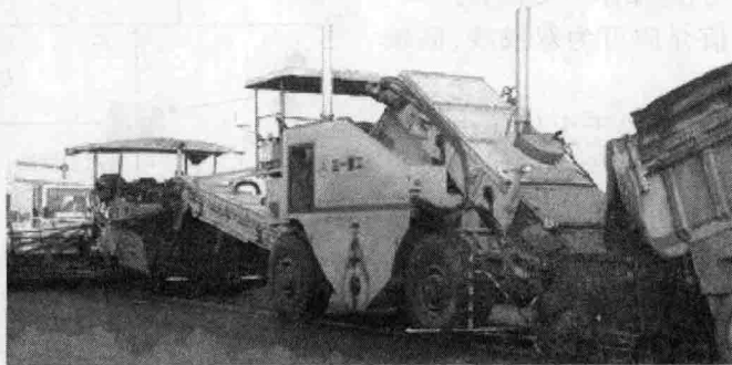
图 1-8 摊铺机、转运车与压路机等机群联合作业
