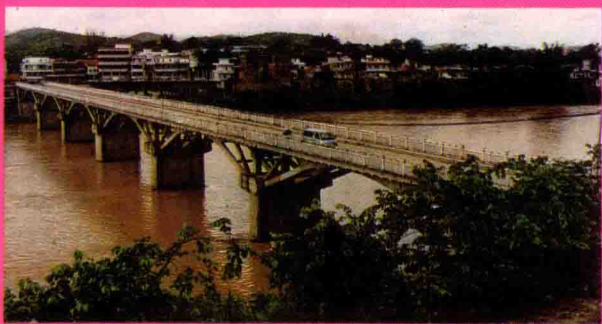
梅县水车大桥
