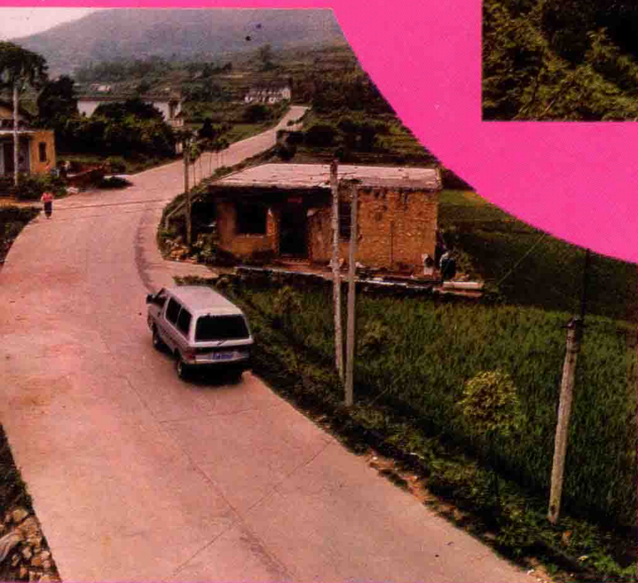
梅县雁洋镇大坪至南福水泥硬底化路面
