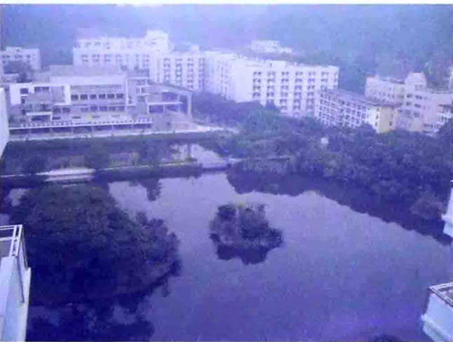
图 1-1 福建农林大学校园景观风貌
