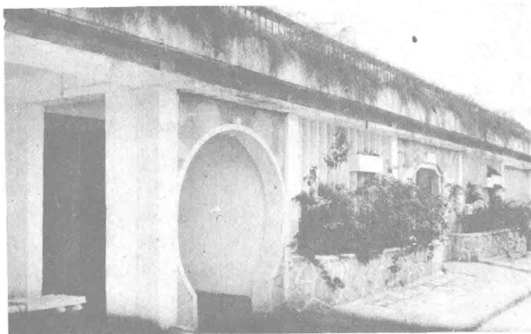
图9 上埗滨江路住宅区的连廊
