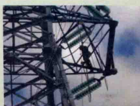
20. 跳线跳通施工
