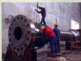
1. 主轴与发导、水导、组合轴承安装
