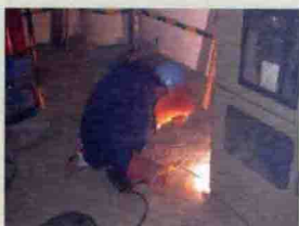
4. 安装电力设备组件
