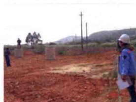
15. 使用经纬仪对基础高度 偏差进行测量
