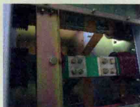
4. 开关柜母线的安装
