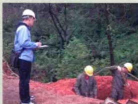
2. 基础人工开挖
