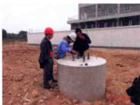
14. 基础根开及对角根开 长度测量
