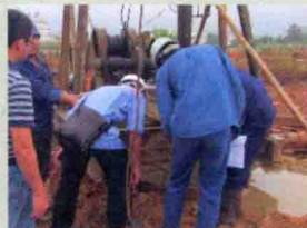
3. 灌注桩基础坑深检查
