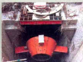
2. 土建以及机组各部件位置安装
