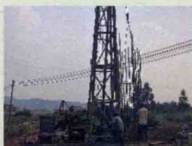
5. 施工人员吊装钢筋笼
