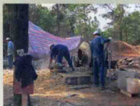
7. 混凝土机械搅拌
