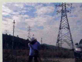
19. 经纬仪测量铁塔倾斜度
