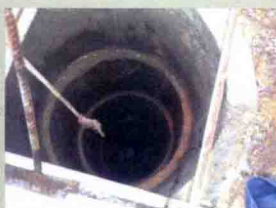
8. 基础坑深测量
