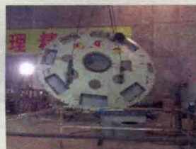
3. 发电机刹车装置、风循环水冷装置、干燥装置吊装
