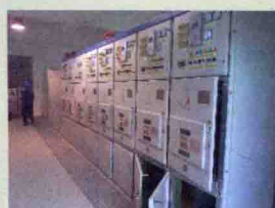
3. 开关柜的安装、二次接线
