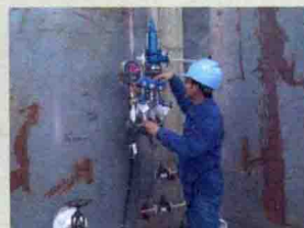
8. 中低压气罐各数值整定
