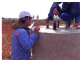
13. 地脚螺栓露高测量
