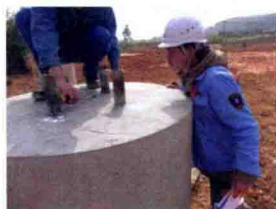
12. 完成基础后——制作 混凝土试块
