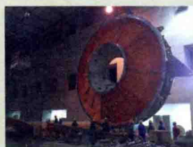
4. 导叶组装以及吊装
