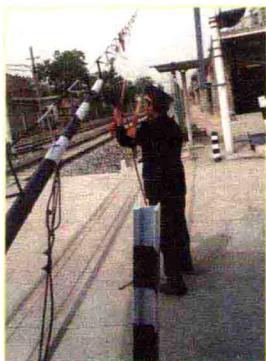
(1)道口工(监护人员)听到车机联控(监听机)、接到通知来车电话、电铃及其他信号报警或发现列车开来时,立即落放栏杆,做好接车准备。
