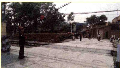
(2)列车通过道口后，监护人员要确认邻线和本线无列车开来，站内道口无调车作业后，方可开启栏杆；若双侧看守，开启栏杆前要互相联系，确认安全后方可开启栏杆；同时，注意防止栏杆上坠落物砸伤行人。
