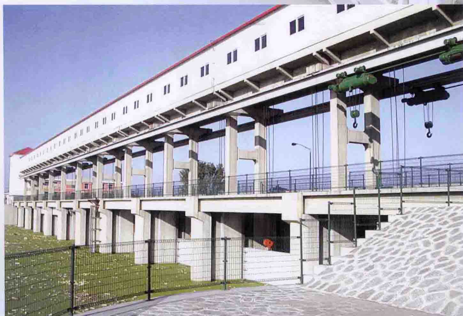
屈家店枢纽永定新河进洪闸
