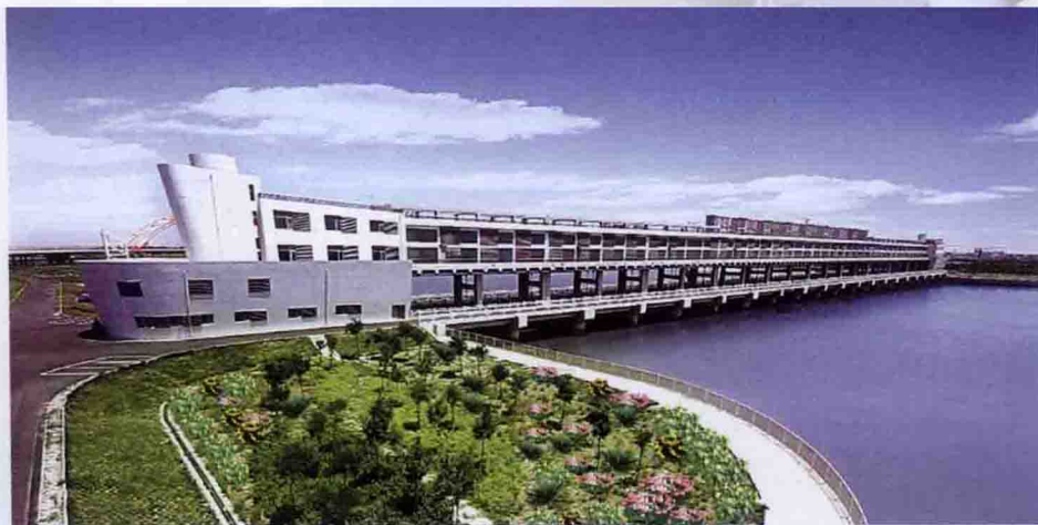
永定新河防潮闸
