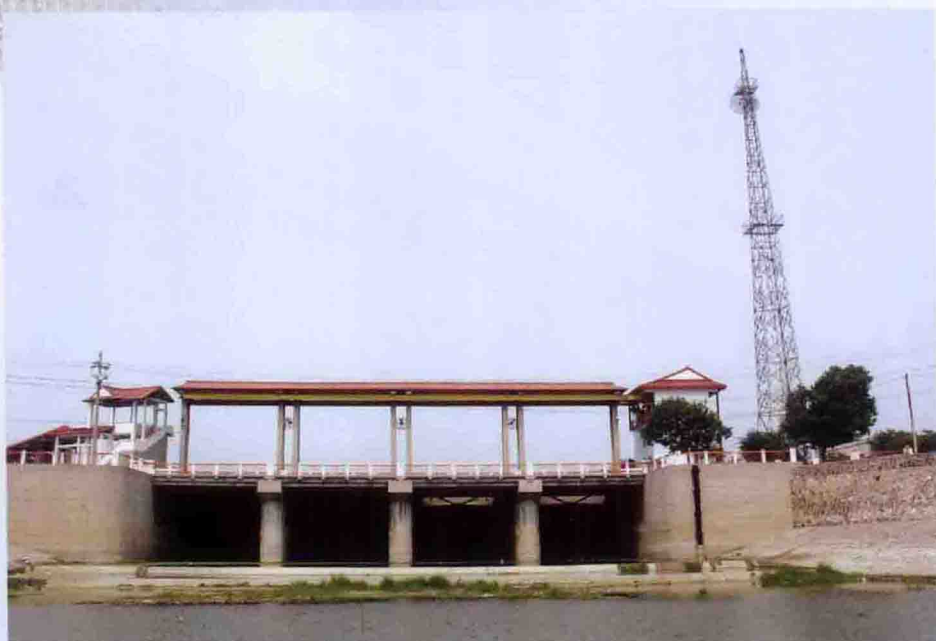
屈家店枢纽新引河进洪闸
