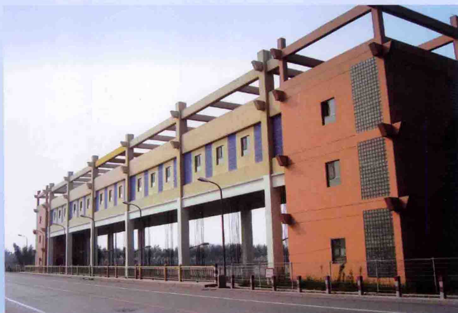
永定河滞洪水库连通闸
