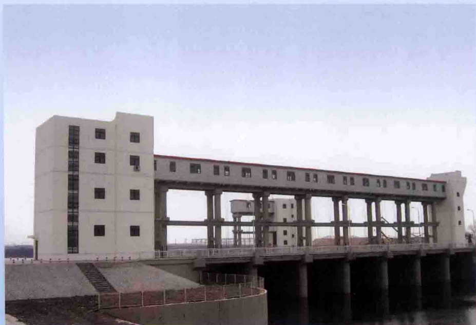
金钟河防潮闸
