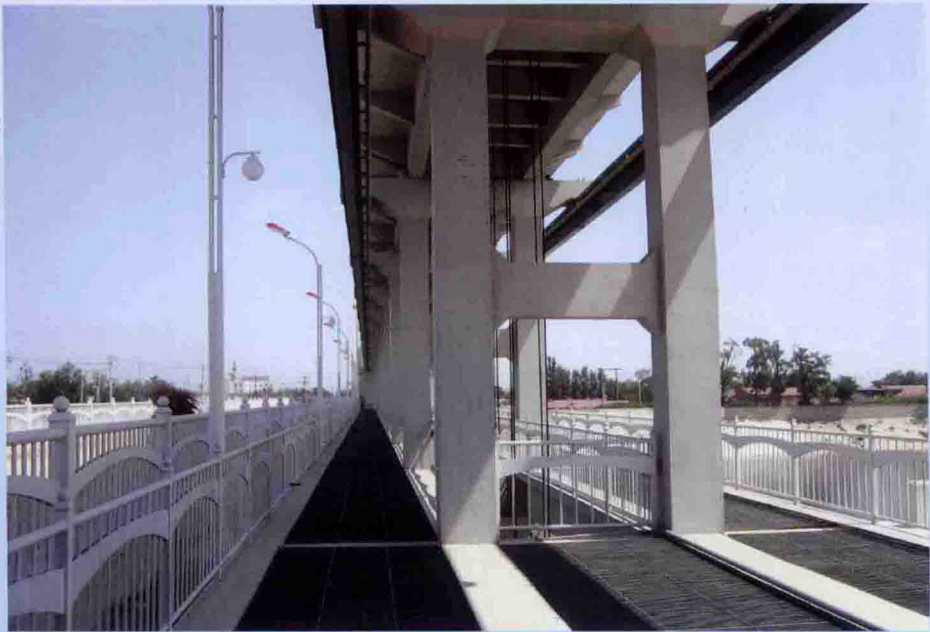
独流减河进洪闸检修桥
