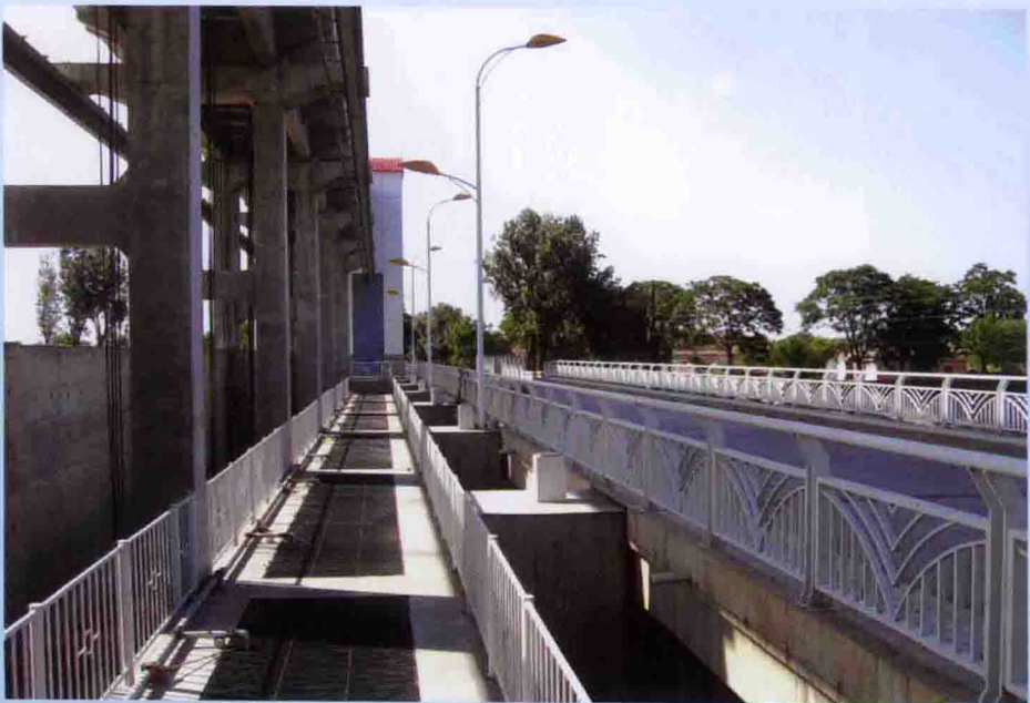
西河闸枢纽节制闸检修桥
