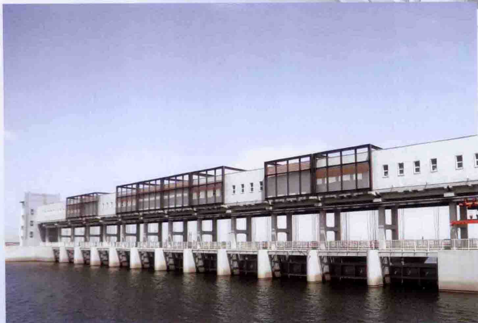
蓟运河防潮闸
