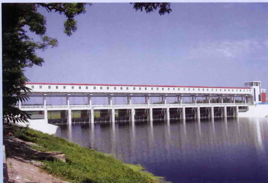
独流减河进洪闸北闸
