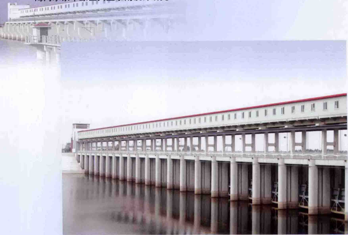
独流减河进洪闸南闸
