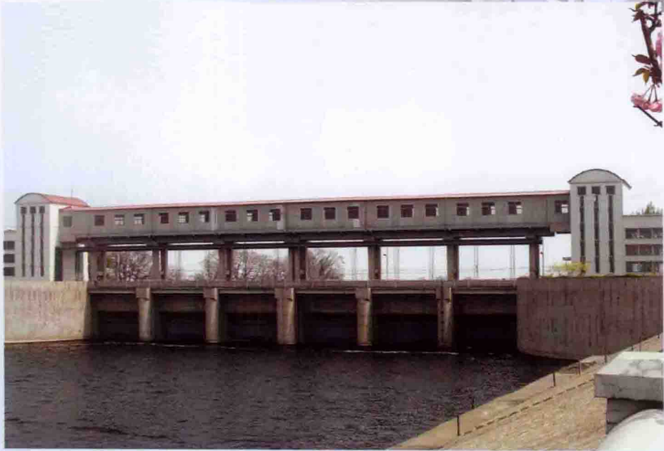
西河闸枢纽节制闸
