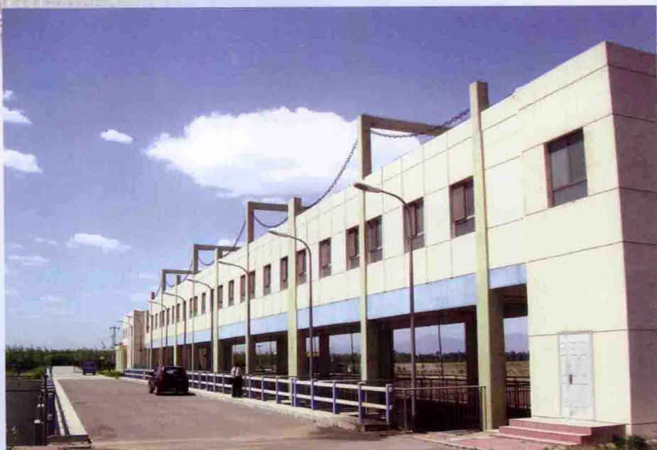
永定河滞洪水库退水闸
