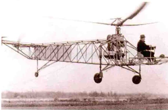
▲1939年9月14日，世界上第一架实用型直升机诞生，它是美国工程师西科斯基研制成功的VS-300直升机。
